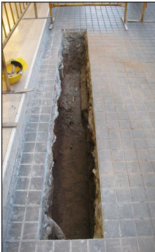
Foto 3: Inici de la rasa 200.
