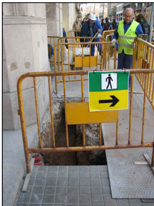
Foto 6: Operaris ultimant feines.
