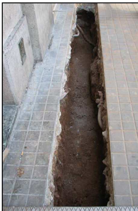
Foto 2: Continuació de la rasa 100.
