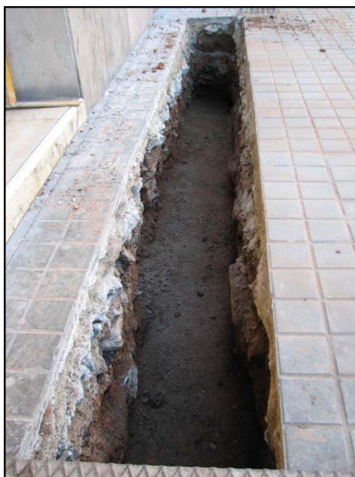
Foto 4: Continuació de la rasa 200.
